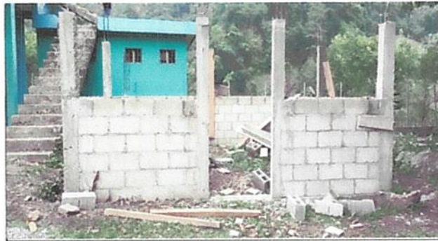
Foto 10: Módulo 3. Cocina: terminar paredes, repello, instalacion de balcones, puerta y techo.
