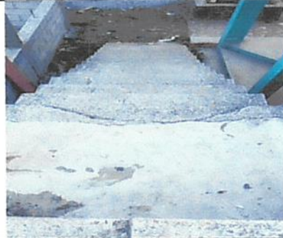
Foto 8: Módulo 2. Terraza : reparacion en las gradass
