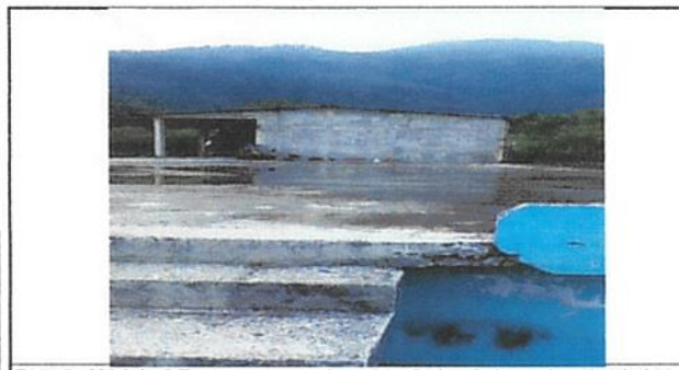
Foto 5: Módulo 2. Terraza : reparacion e instalacion de barandas alrededor de la terraza y en las gradas
