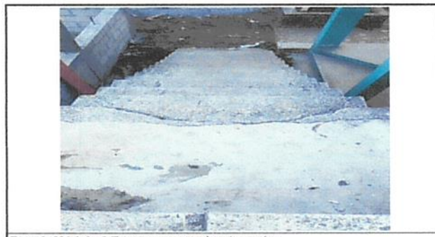
Foto 6: Módulo 2. Terraza : reparacion de gradas
