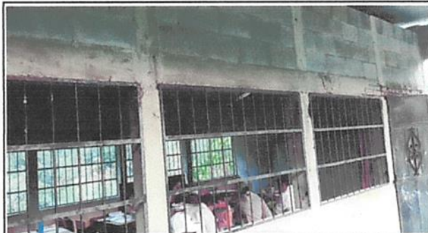
Foto 2: Módulo 1. aula: repello de paredes
