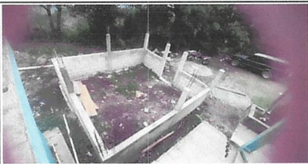
Foto 11: Módulo 3. Cocina: instalacion de piso de torta.
