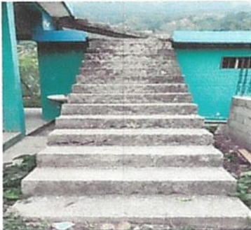
Foto 9: Módulo 2. Terraza : instalacion de barandas en gradass
