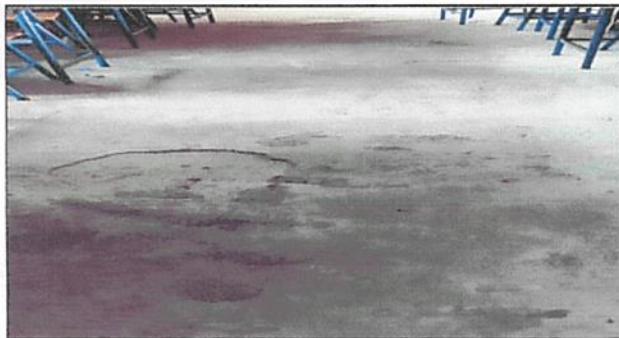
Foto 3: Módulo 1. aula: instalacion de piso ceramico
