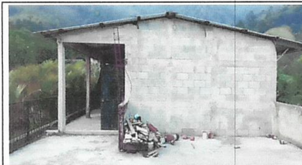
Foto 1: Módulo 1. aula: repello de paredes
